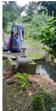
ユンボで不要の コンクリート枠の 除去
