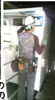
入口から移動できない 機械の解体作業
