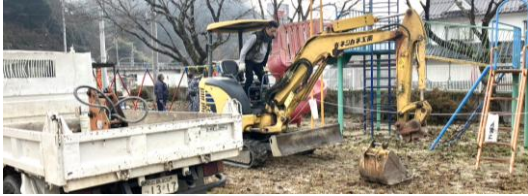
遊具の撤去工事
